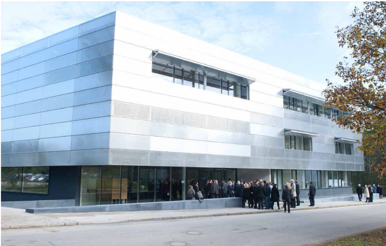
Eine innovative Fassade umhüllt den Neubau des HIU, der auf 2 400 Quadratmetern Platz für das wissenschaftliche Arbeiten von rund 100 Mitarbeiterinnen und Mitarbeitern bietet
