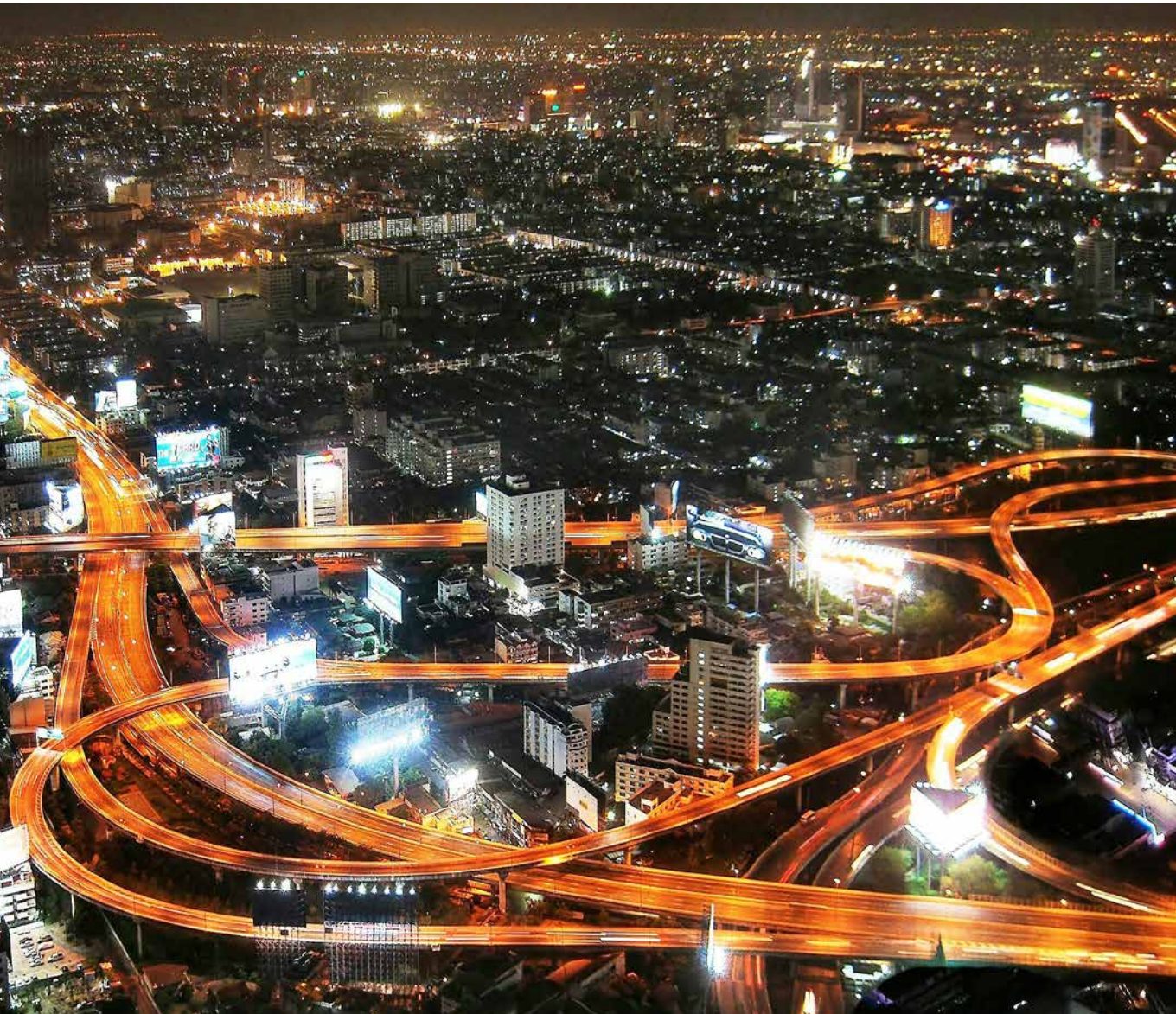
Unverzichtbar für die städtischen Infrastrukturen: elektrischer Strom. Leitungsverluste verringern den Wirkungsgrad von Stromnetzen
