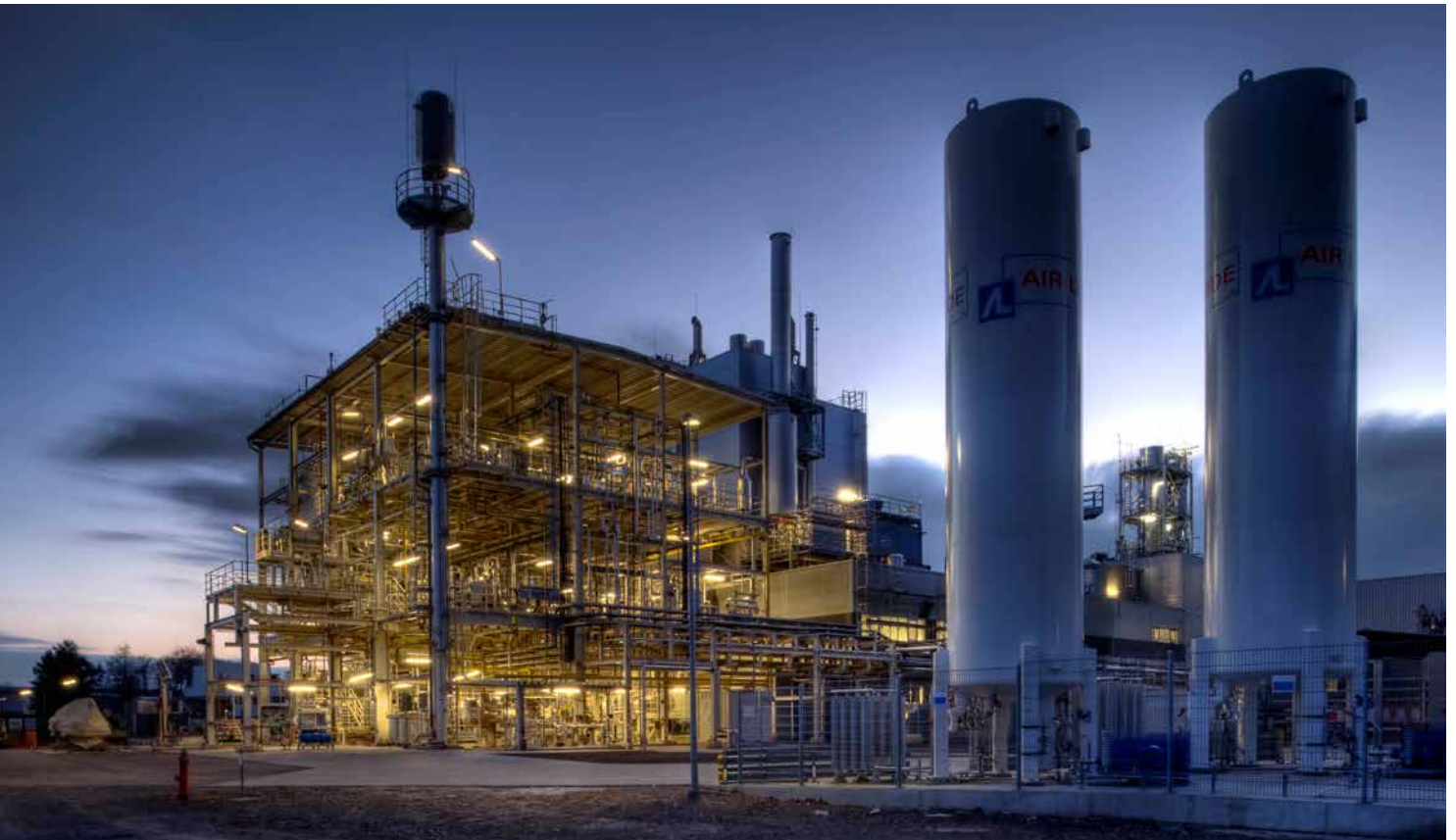
Aus Restbiomasse, beispielsweise Holz oder Stroh, werden in der bioliq®-Pilotanlage umweltfreundliche Designer-Kraftstoffe hergestellt
